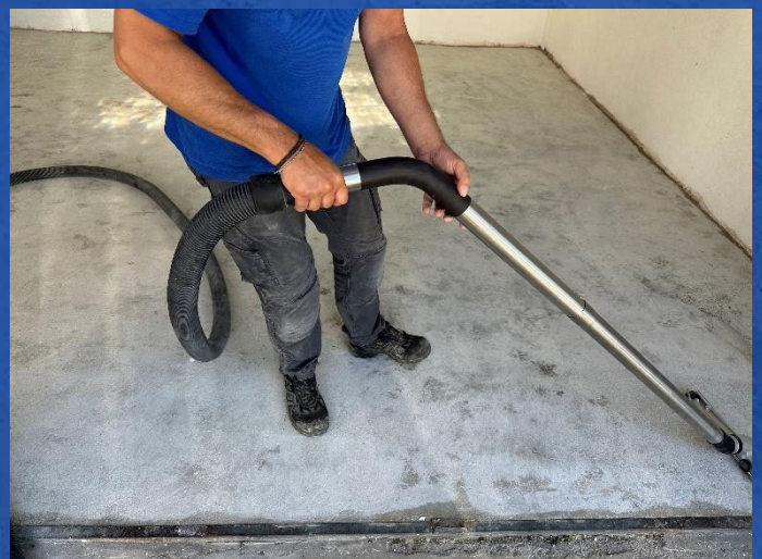
Absaugen mit Staubsauger
