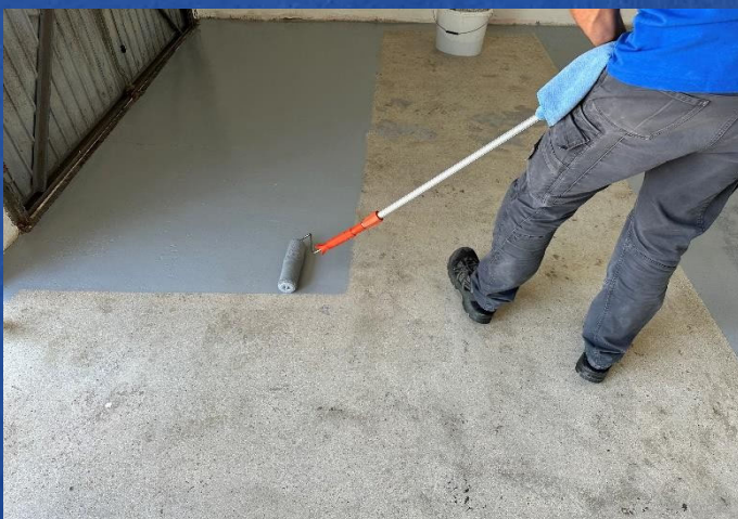
Aufrühren und zweimal mit kurzflorigem Mikrofaserroller aufbringen
